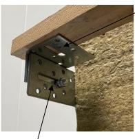
Fixation de la rallonge par 1 boulon TRCC et 1 rondelle anti-desserrage
